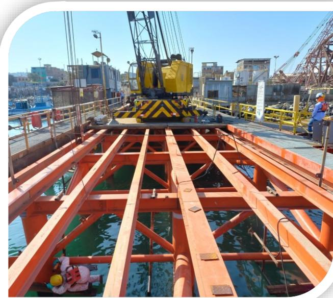
Montaje de vigas longitudinales en la reparación del muelle tortuga SAVIA PERU
