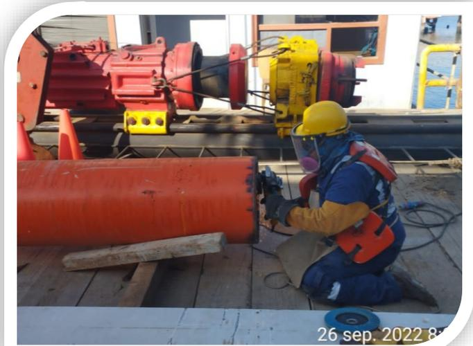
Preparación de pilote de acero en la reparación del muelle tortuga SAVIA PERU
