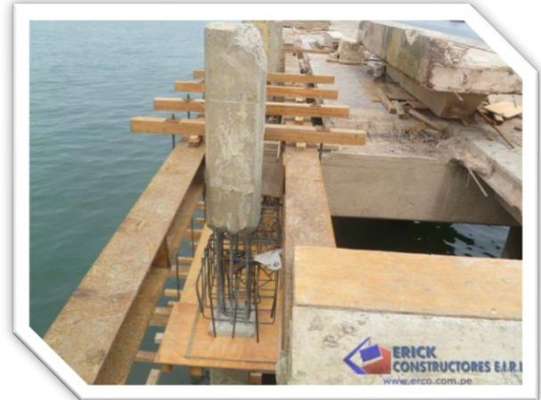
Hincado de pilotes en la reparación del muelle centenario - Chimbote
